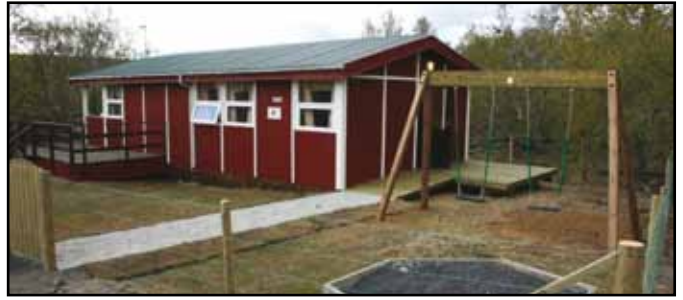
Framsýn hefur látið gera nokkrar lagfæringar á bústað félagsins í Dranghólaskógi í Öxarfirði. Búið er að mála hann að utan og laga aðgengi að honum. Auk þess er búið að setja upp rólu fyrir ungu kynslóðina. Það voru verktakarnir Guðmundur Halldórsson málarameistari og Garðvirk ehf. sem sáu um framkvæmdirnar. Bústaðurinn er nú kominn í legu fram á haustið. Mikil ástæða er í bústaðinn sem þarf ekki að koma á óvart enda á mjög fallegum og skjólsömum stað.
