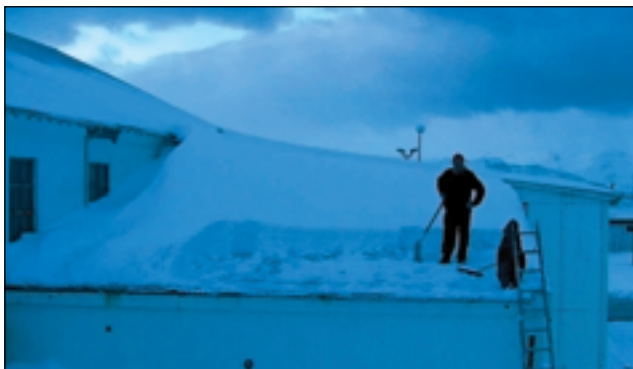
Kunnugleg sjón á Húsavík. Ásbjörn Björgvinsson er einn af þeim sem orðið hefur að moka snjó af þökum vegna fannfergis. Hér er hann að moka af þaki Hvalamiðstöðvarinnar. Þess má geta að nú er unnið að því að stækka safnið sem væntanlega verður lokið í vor.
