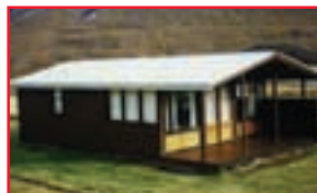
Illugastaðir, Fnjóskadal 3 svefnherb. Útv. / Sjónv. / Grill
