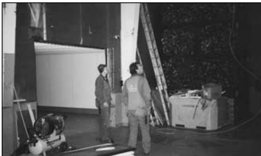
Látum okkur nú sjá!! Töluvert hefur verið um framkvæmdir hjá Laugafiski í Reykjadal og hér má sjá tvo starfsmenn Norðurlþóls sem komið hafa að þeim framkvæmdum.
